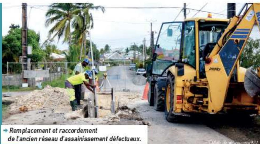
→ Remplacement et raccordement de l'ancien réseau d'assainissement défectueux.
